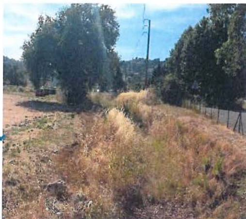
FIGURE 35 : VALLON DE MADE – CHEMIN DE VALLAURIS
