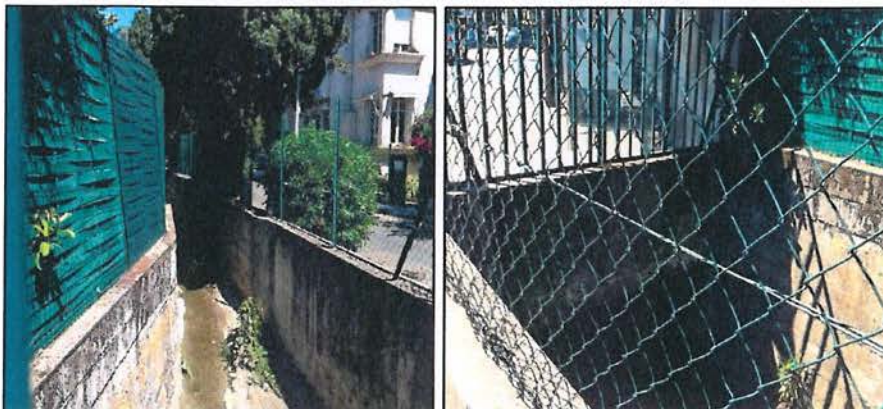
FIGURE 29 : VALLON DES FRERES GARBERO EN AVAL DE L'HOPITAL – ENTREE PASSAGE COUVERT
