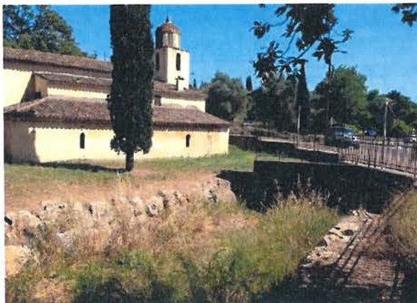
FIGURE 20 : VALLON DU ST-MAYMES AVANT DE PASSER SOUS LA ROUTE DEPARTEMENTALE
