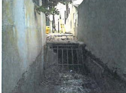
FIGURE 65 : TRANSITION DU LYS VERS LE RESEAU PLUVIAL
