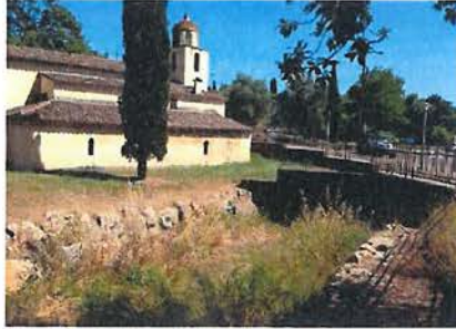
FIGURE 33 : ENTREE PASSAGE COUVERT CHAPELLE ST JEAN
