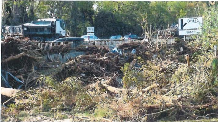
FIGURE 26 : FORMATIONS D'EMBACLES LORS DE LA CRUE DU 3 OCTOBRE 2015 SUR LE PONT DE L'AUTOROUTE A8
